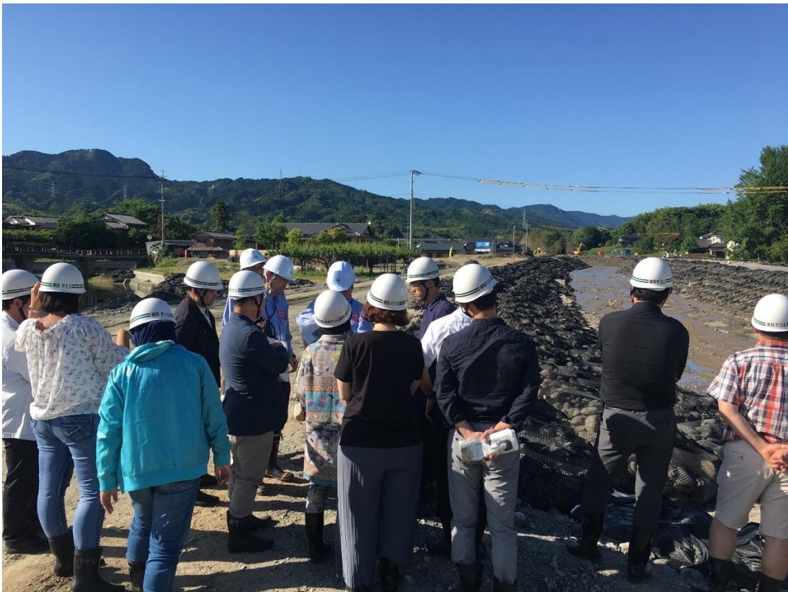
乙石川（赤谷川の上流）の復旧現場視察
